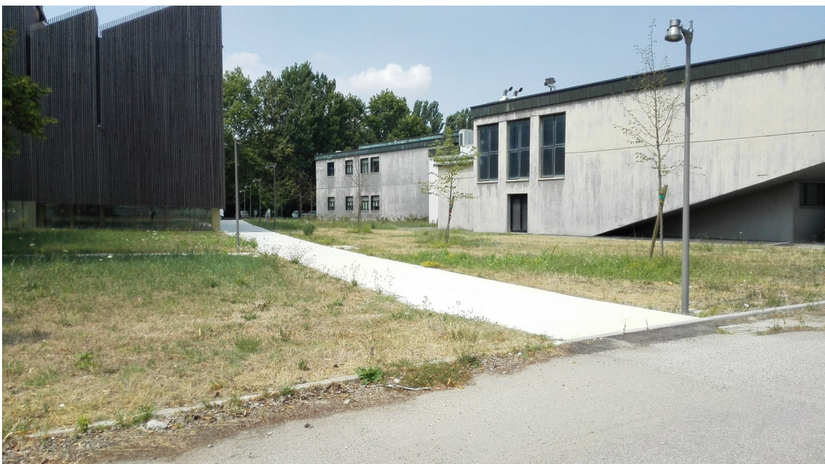
Area esterna nord-est – percorso pedonale verso la piazza con tigli
