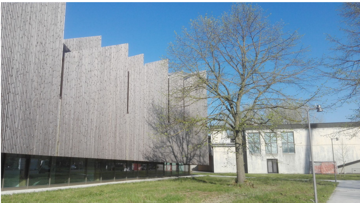
Area esterna nord-est – percorso pedonale verso la piazza verde
